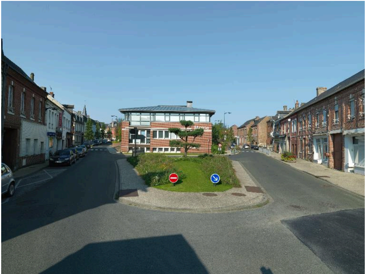
Vue générale des extensions de la mairie d'Escarbotin.
