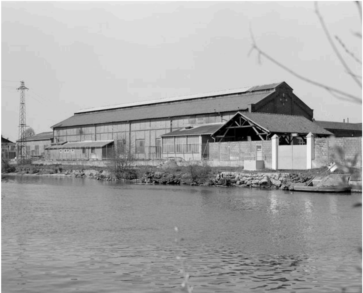
Magasin industriel : vue générale.
