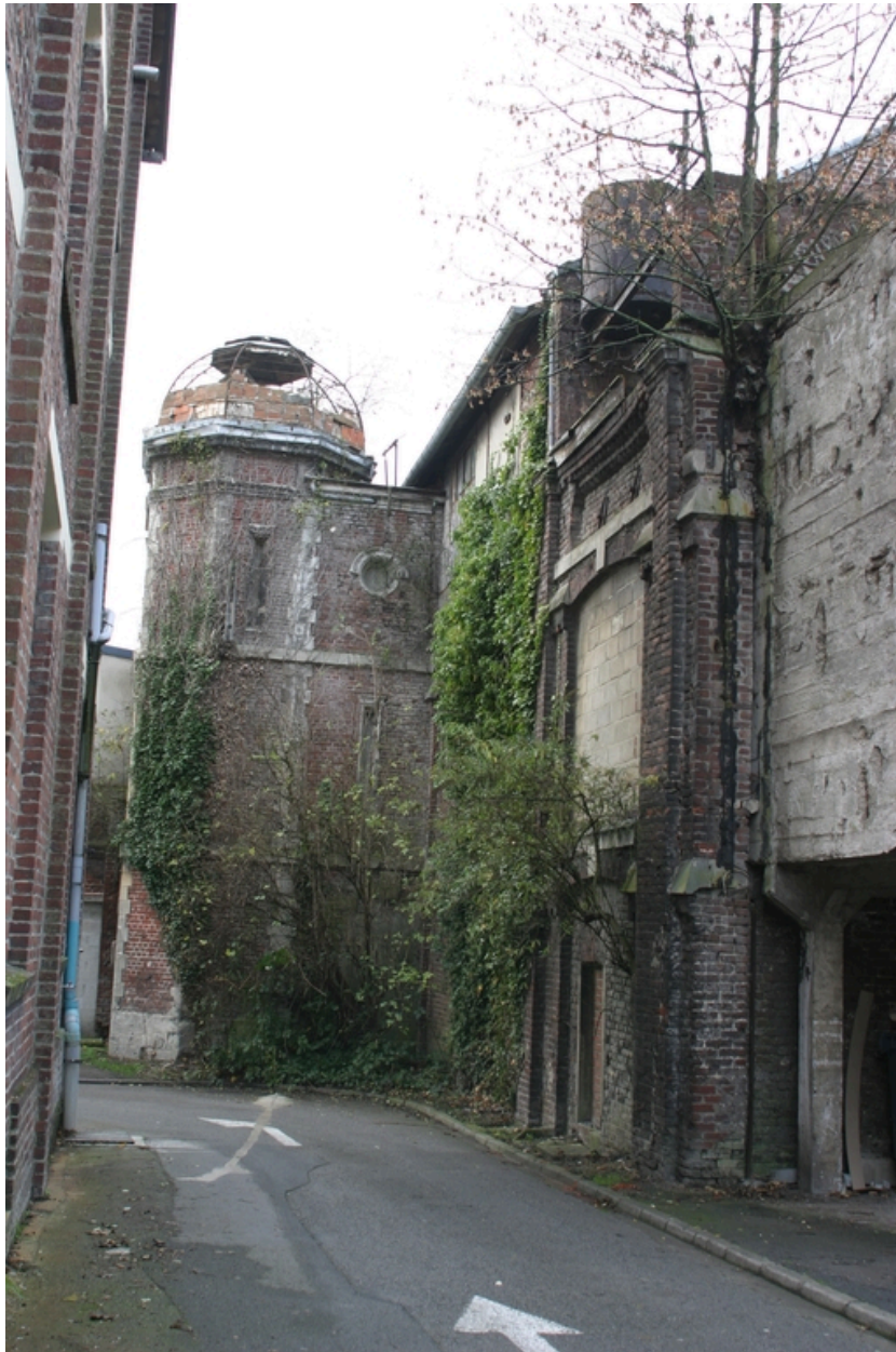
Tour d'escalier et atelier d'apprêt.
