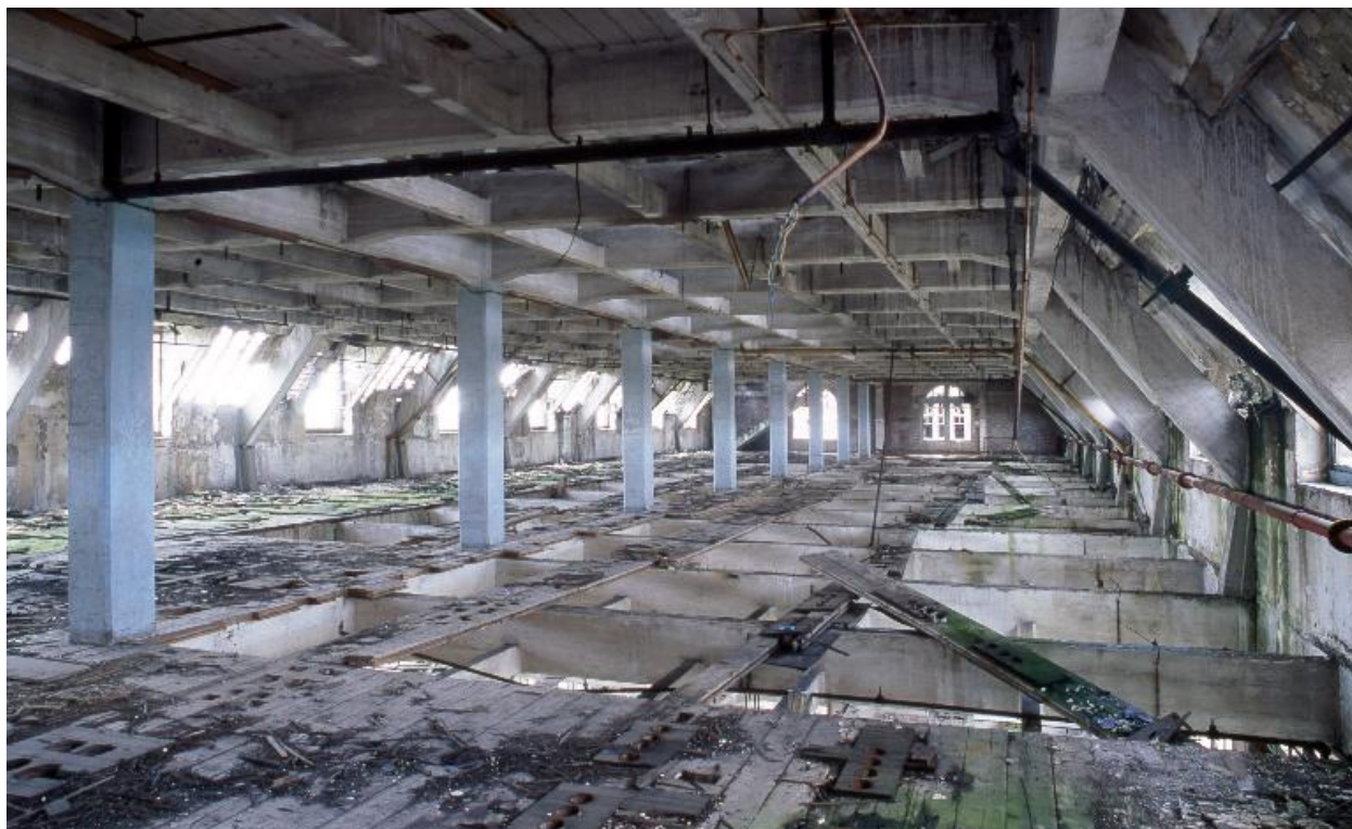
Bâtiment des moulins. Premier niveau de comble.
