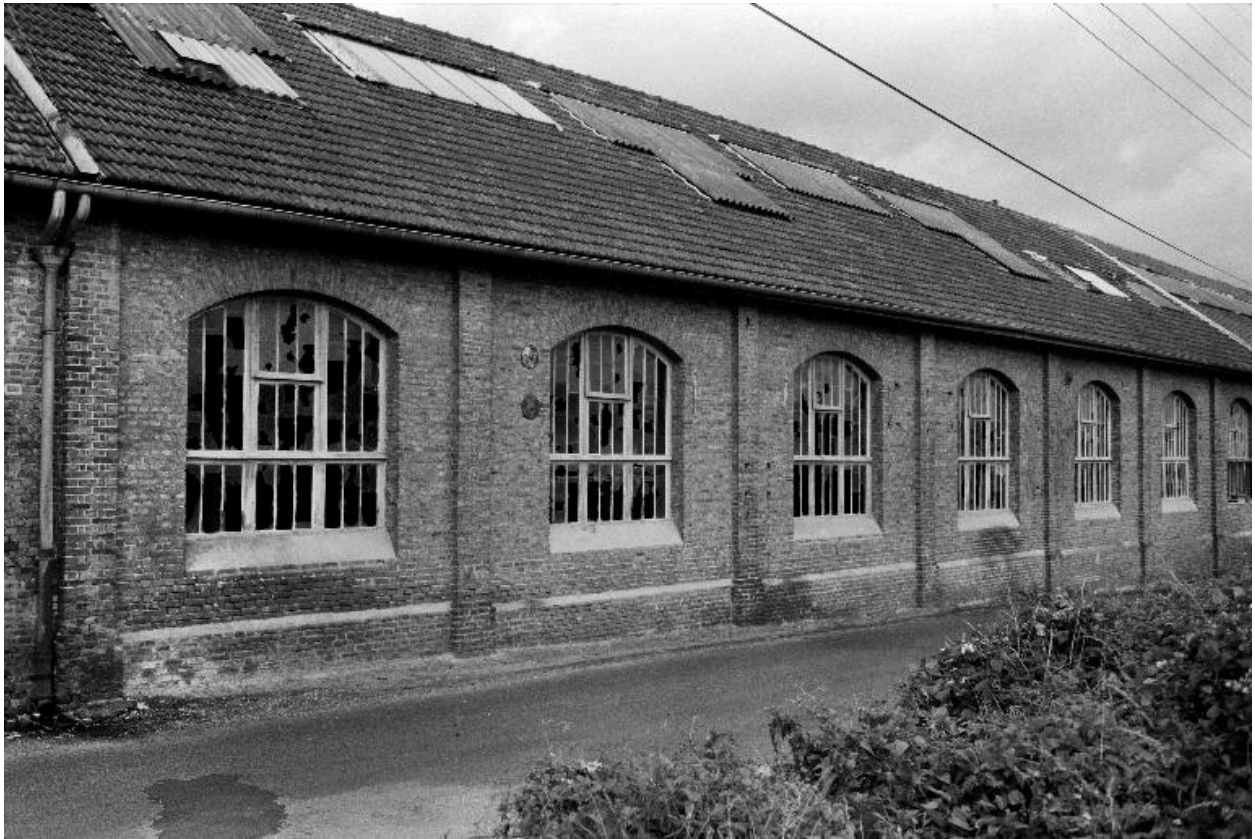
Atelier de fabrication, vue partielle, flanc est.
