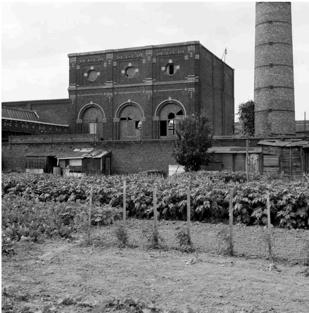
Vue générale depuis les jardins ouvriers, vers le sud-est. La salle des machines et la cheminée.
