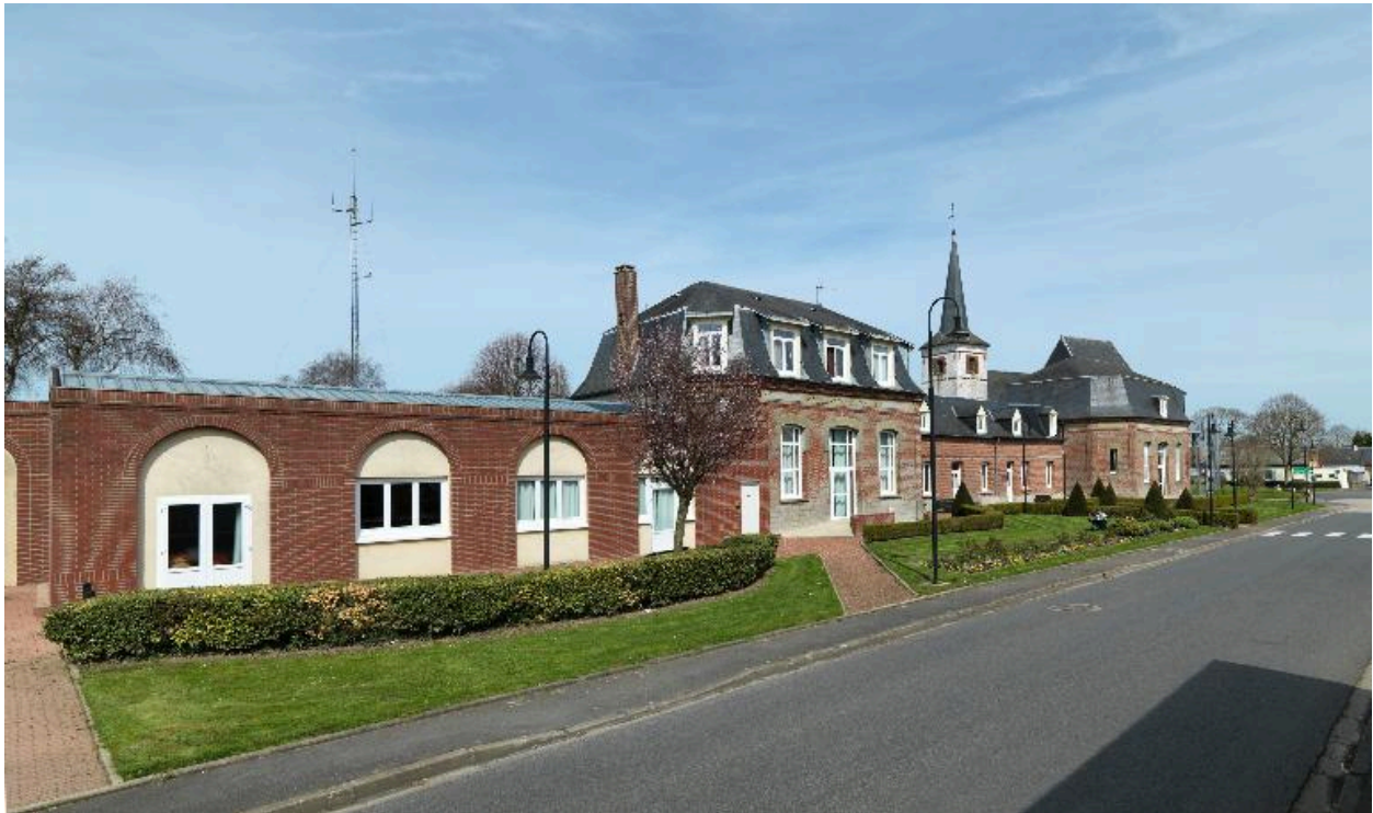
Vue générale depuis la rue Ferdinand-Buisson.
