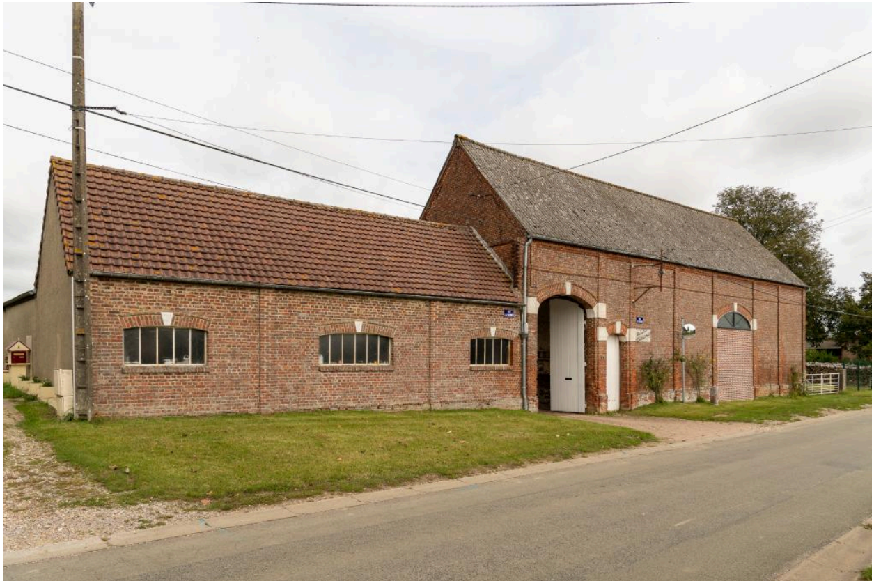
Grange et ateliers, n°1 rue du Pressoir, vue depuis le sud-ouest.
