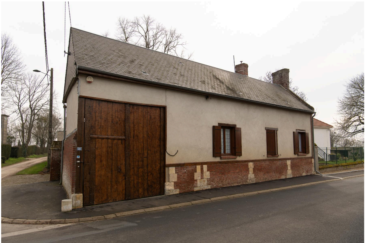
Ancien café, n°581 rue des Hêtres, vue prise depuis le nord.
