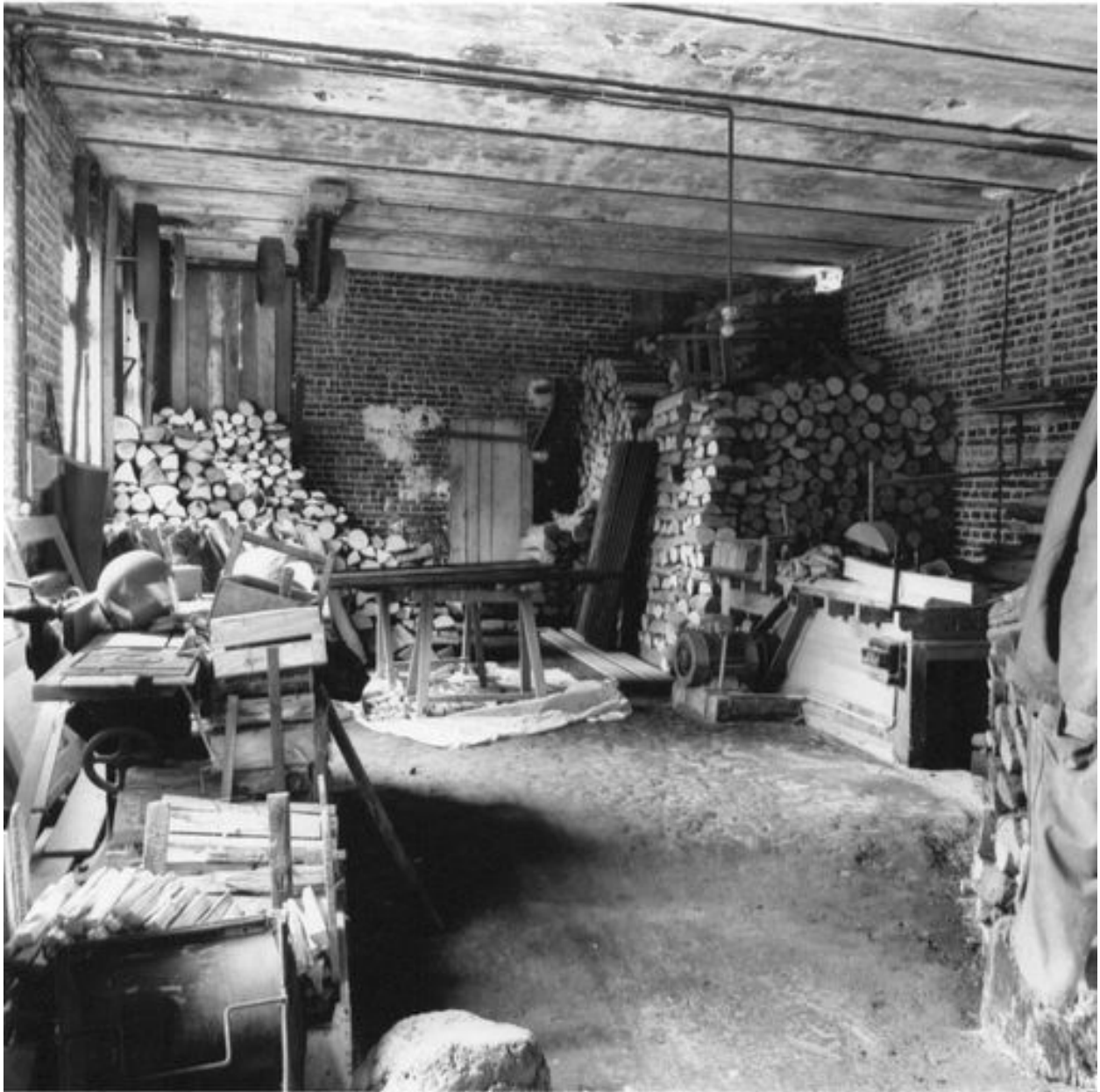
Intérieur de l'atelier de sciage.
