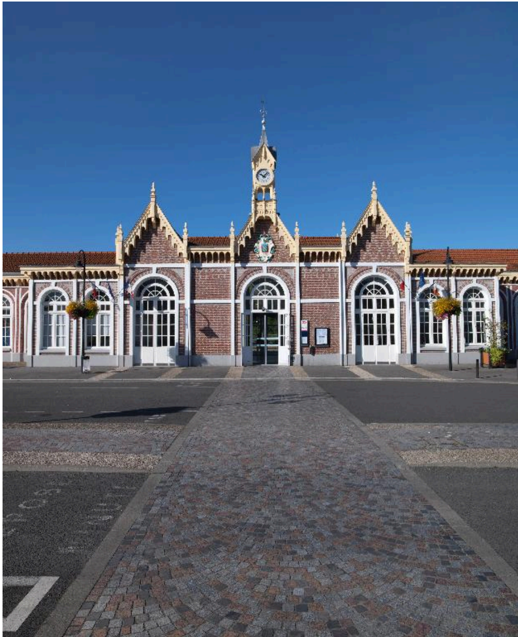
Avant-corps de la façade principale.
