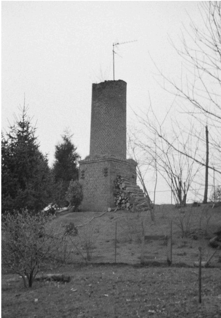
Vestiges de la cheminée détruite en 1918.
