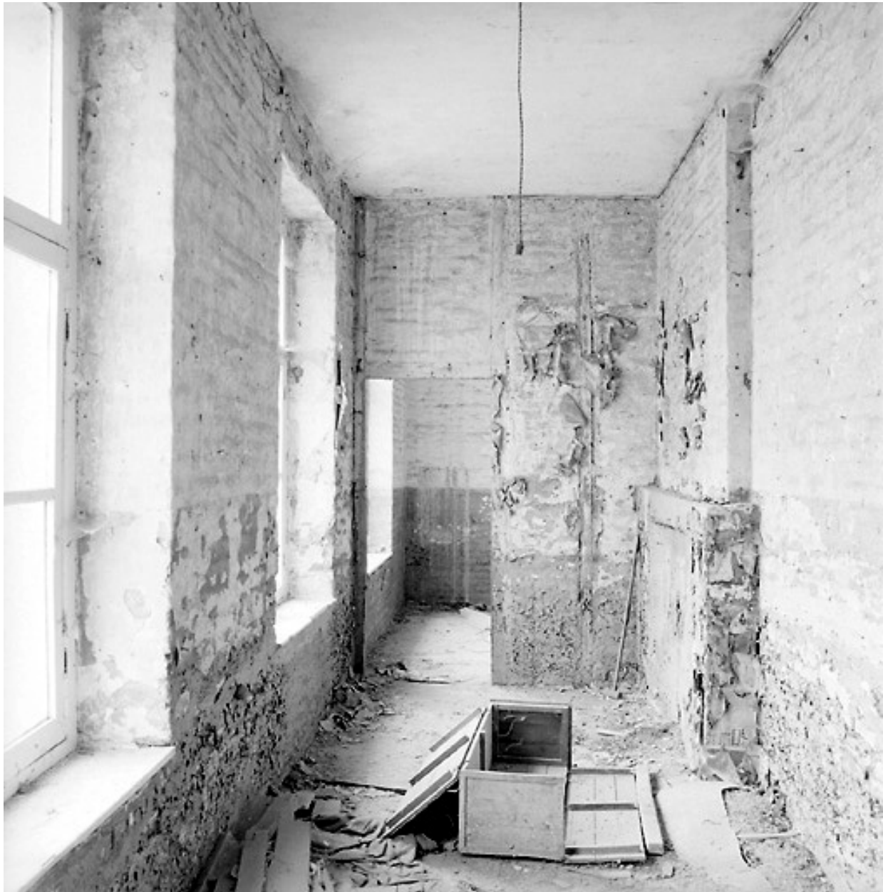
Corps de garde, intérieur, second étage à usage de logement : salle sud-ouest, état en 2005.
