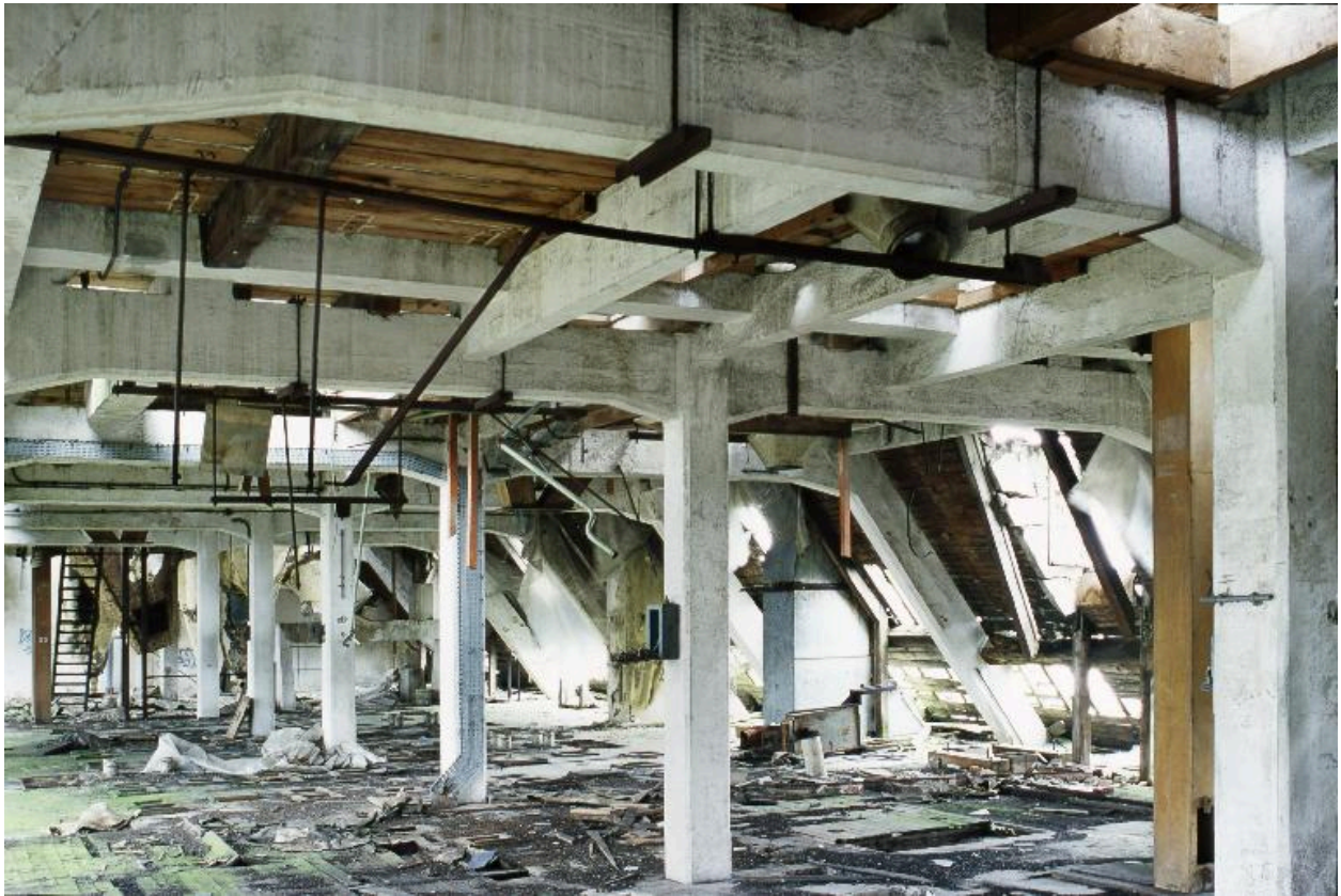
Bâtiment des moulins. Deuxième niveau de comble.
