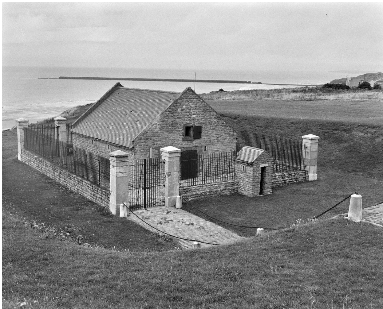
Vue d' angle nord.
