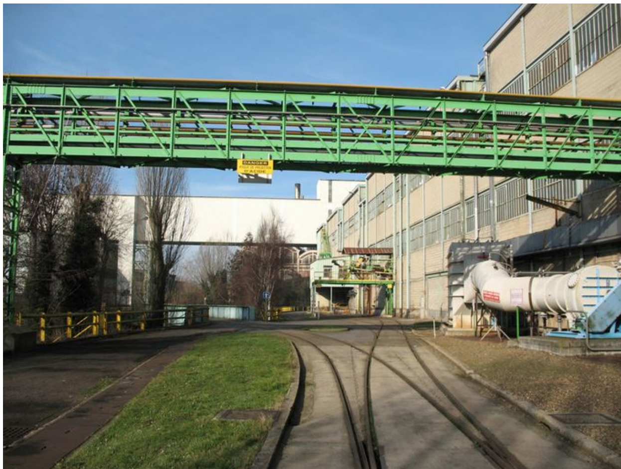
Rails longeant les ateliers abritant le laminoir.
