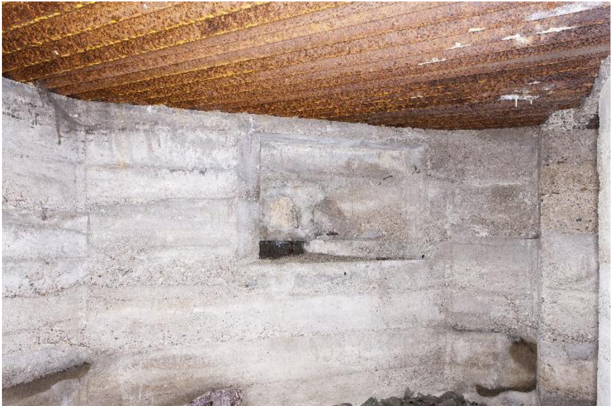
Casemate nord. Seconde salle. Ouverture de tir nord, condamnée
