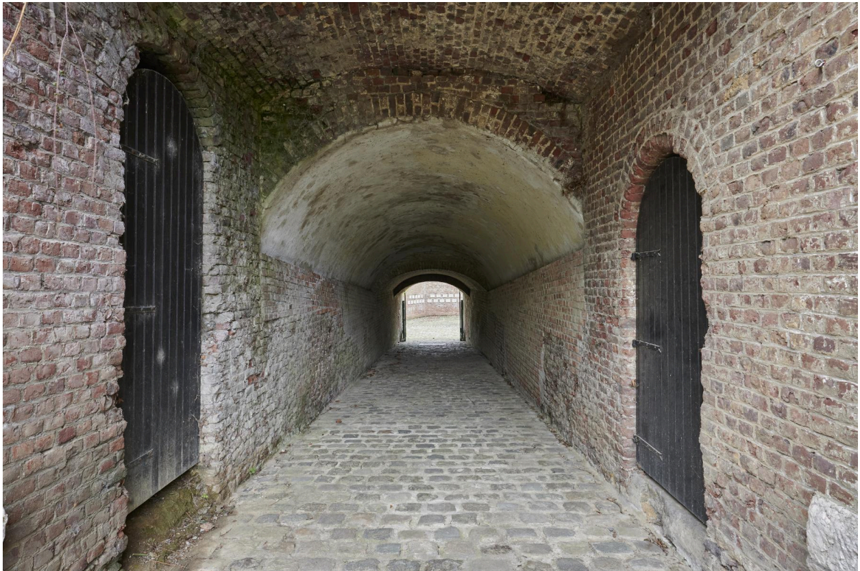
Passage couvert menant à la chambre des poudres ouest.
