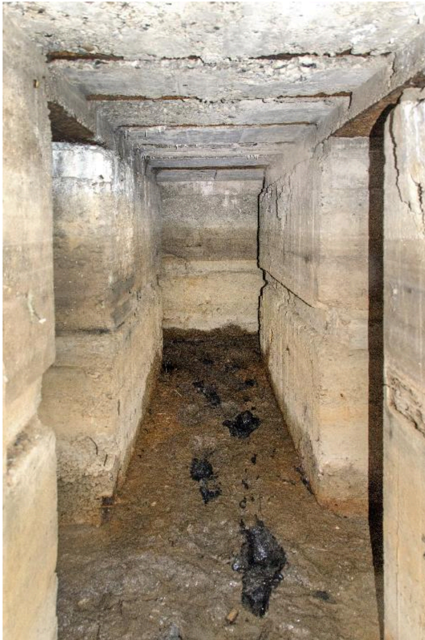
Couloir C2, vers le nord
