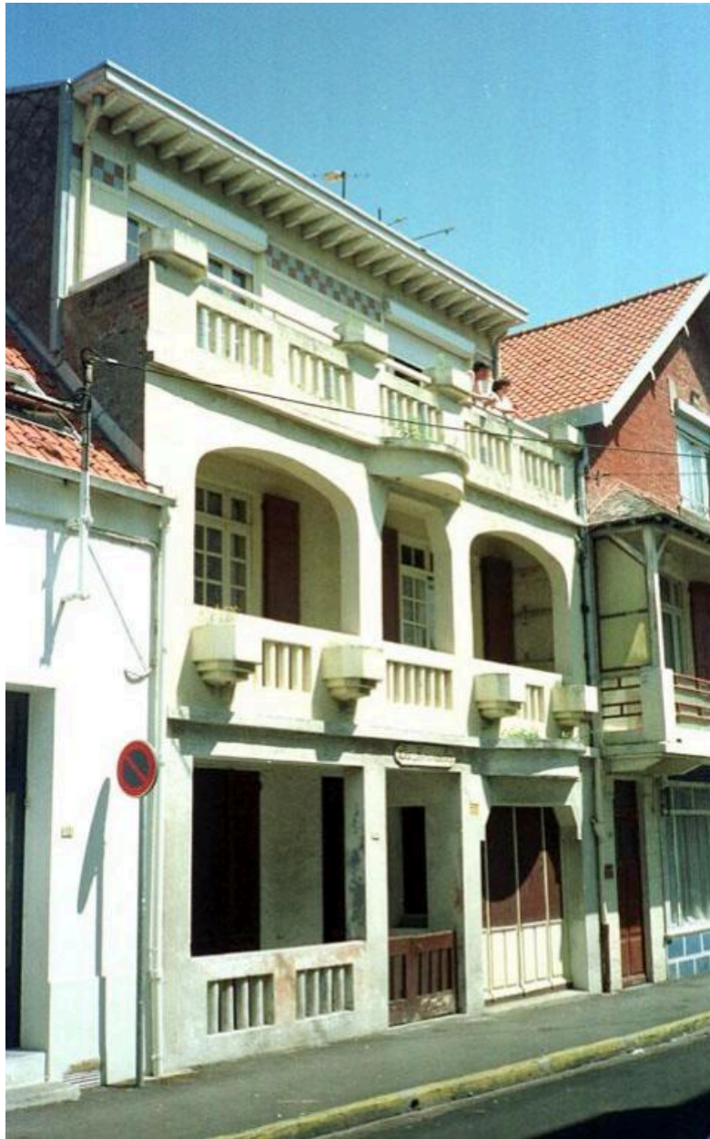
Vue d'ensemble de la façade.
