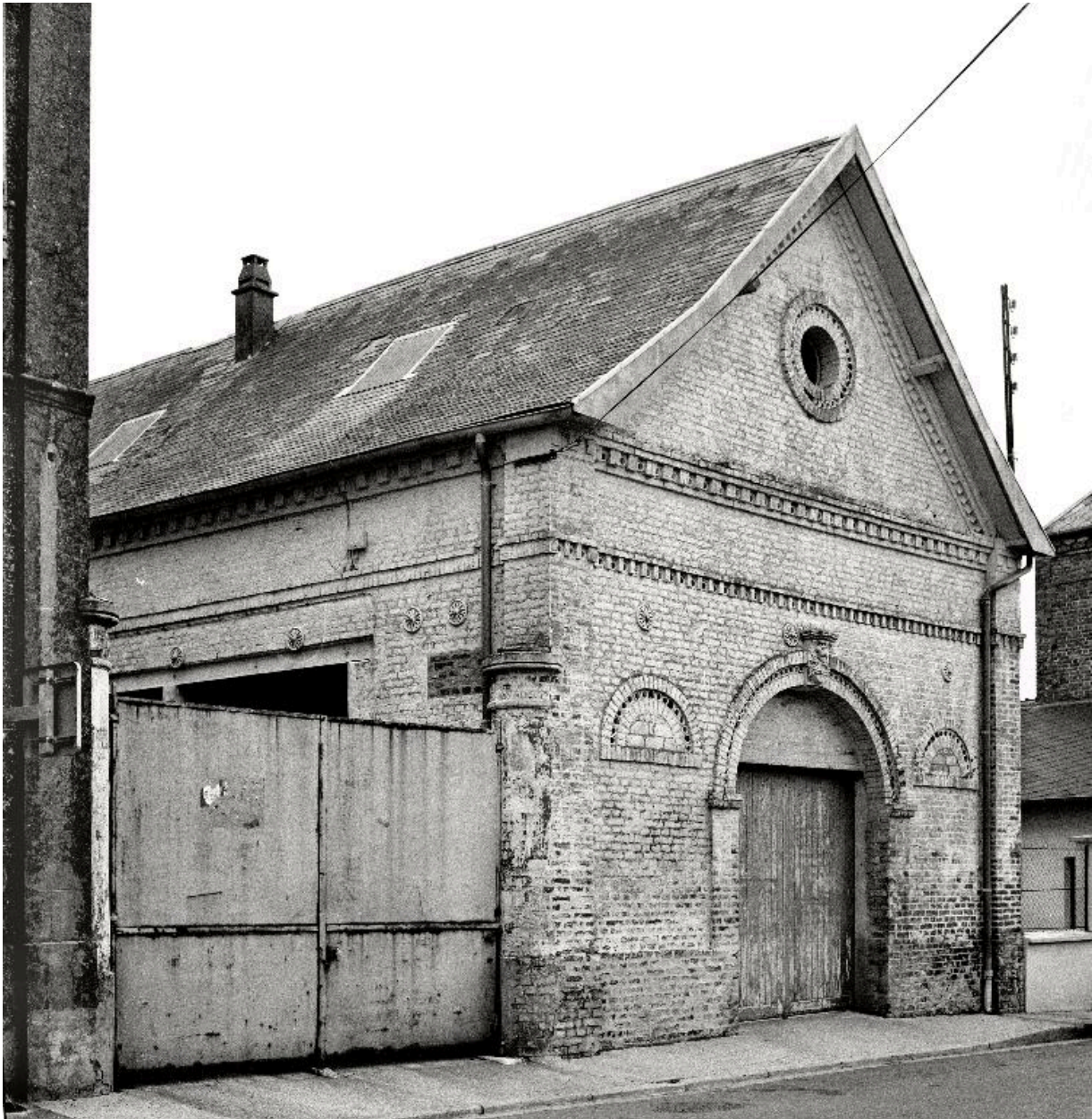
Vue partielle de l'entrepôt de marchand de vins transformé en atelier, en 1990.
