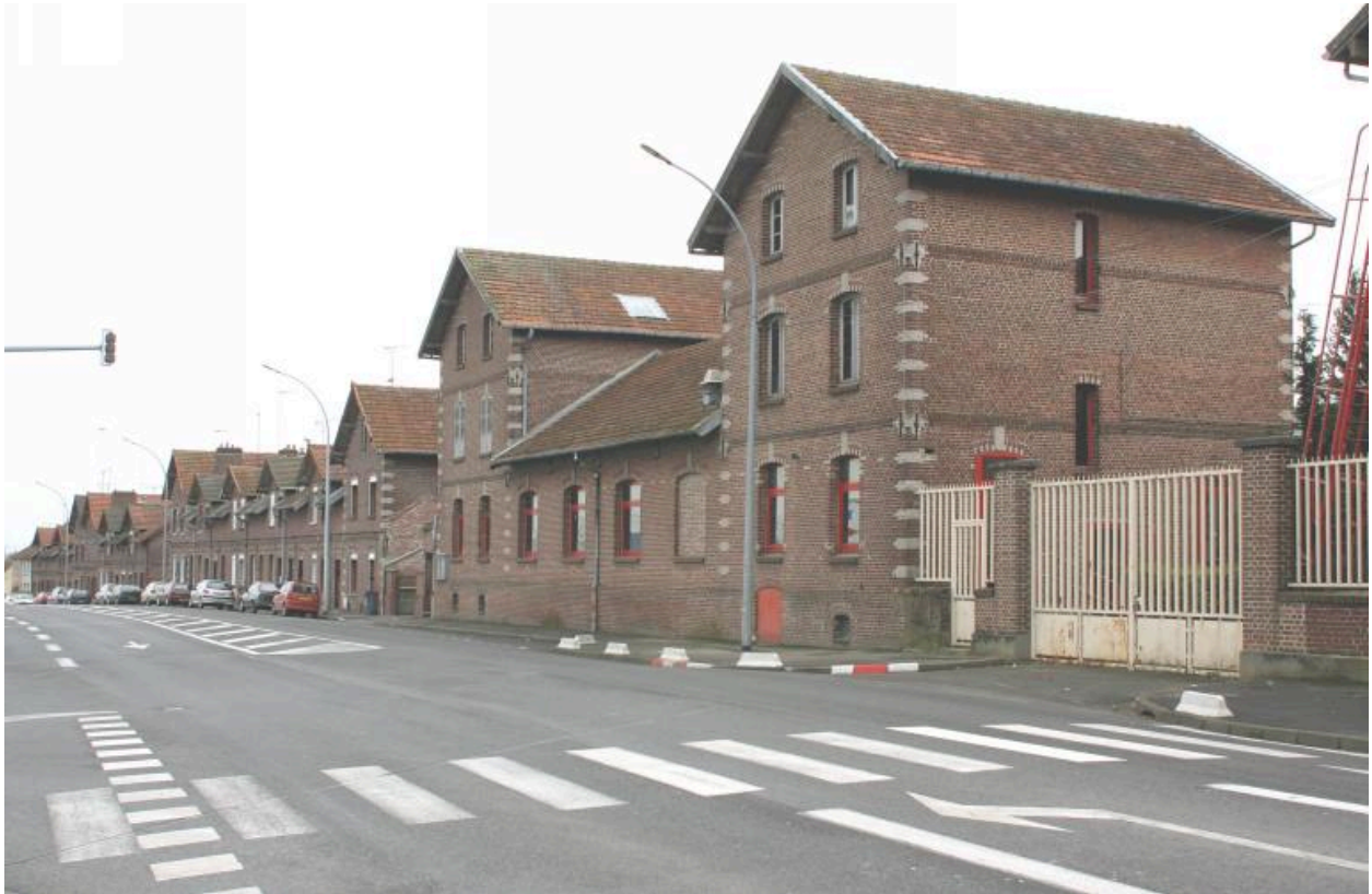
Vue d'ensemble de la cité ouvrière : au premier plan, la cantine de l'usine Daltroff.
