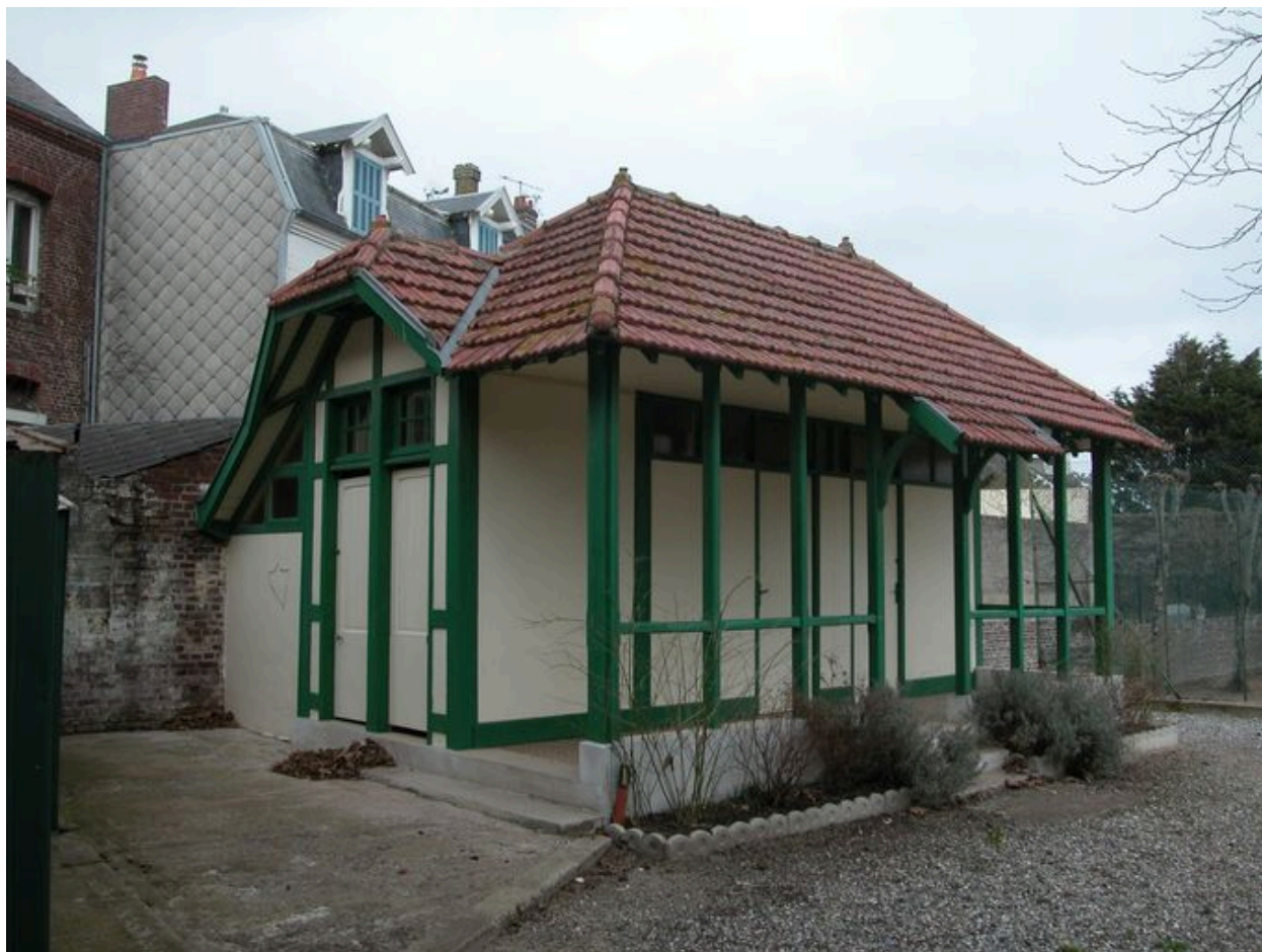
Les vestiaires, vue de trois-quarts.
