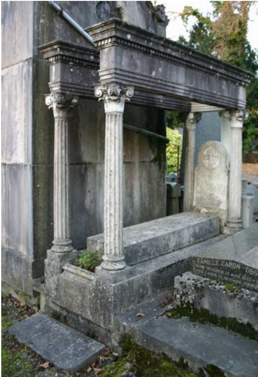
Vue générale, depuis le côté.
