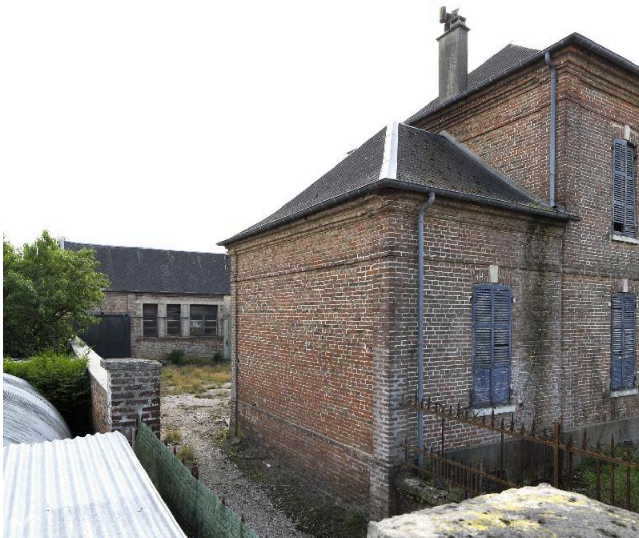
Vue d'une partie des ateliers situés à l'arrière du logement patronal.
