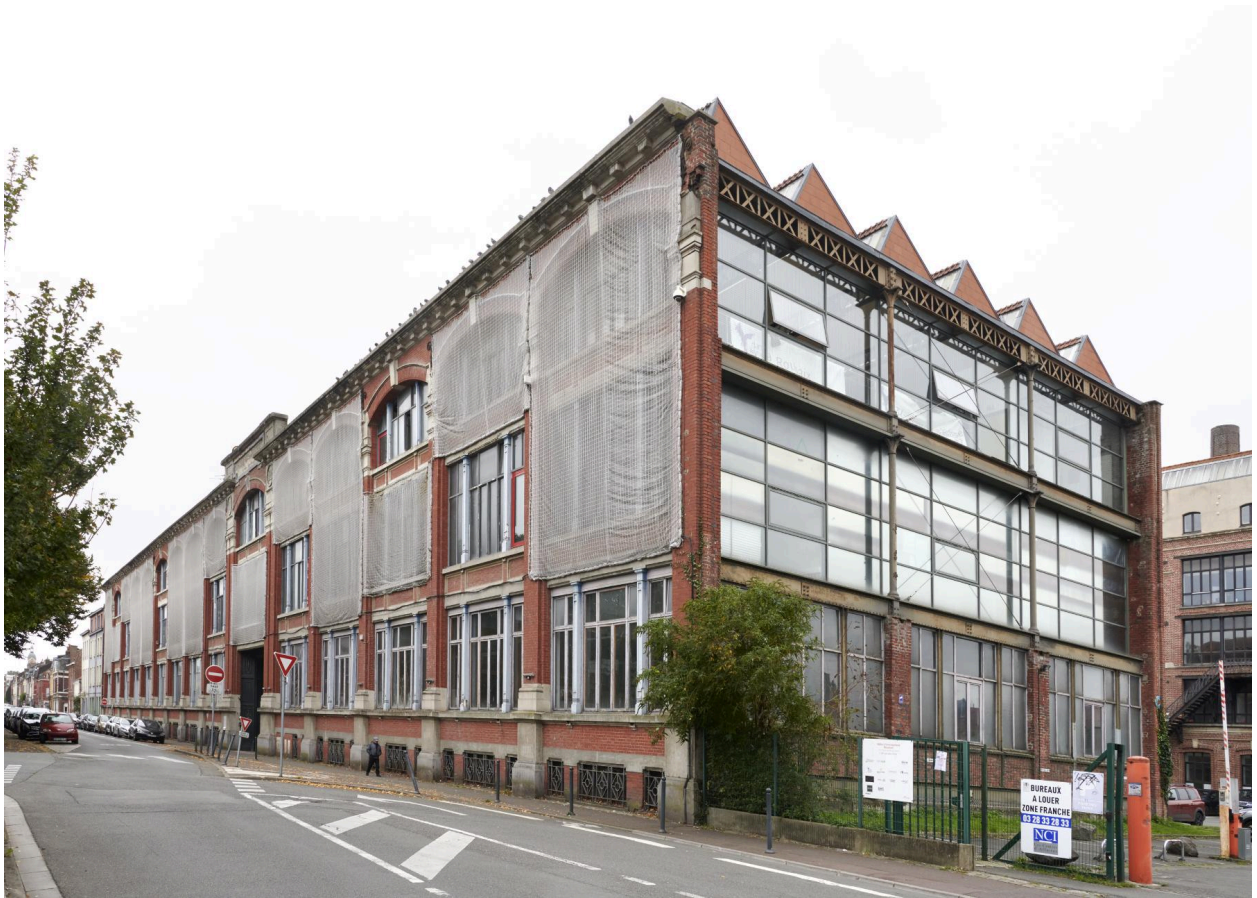
Bâtiment donnant rue des Arts, vue générale de la façade.
