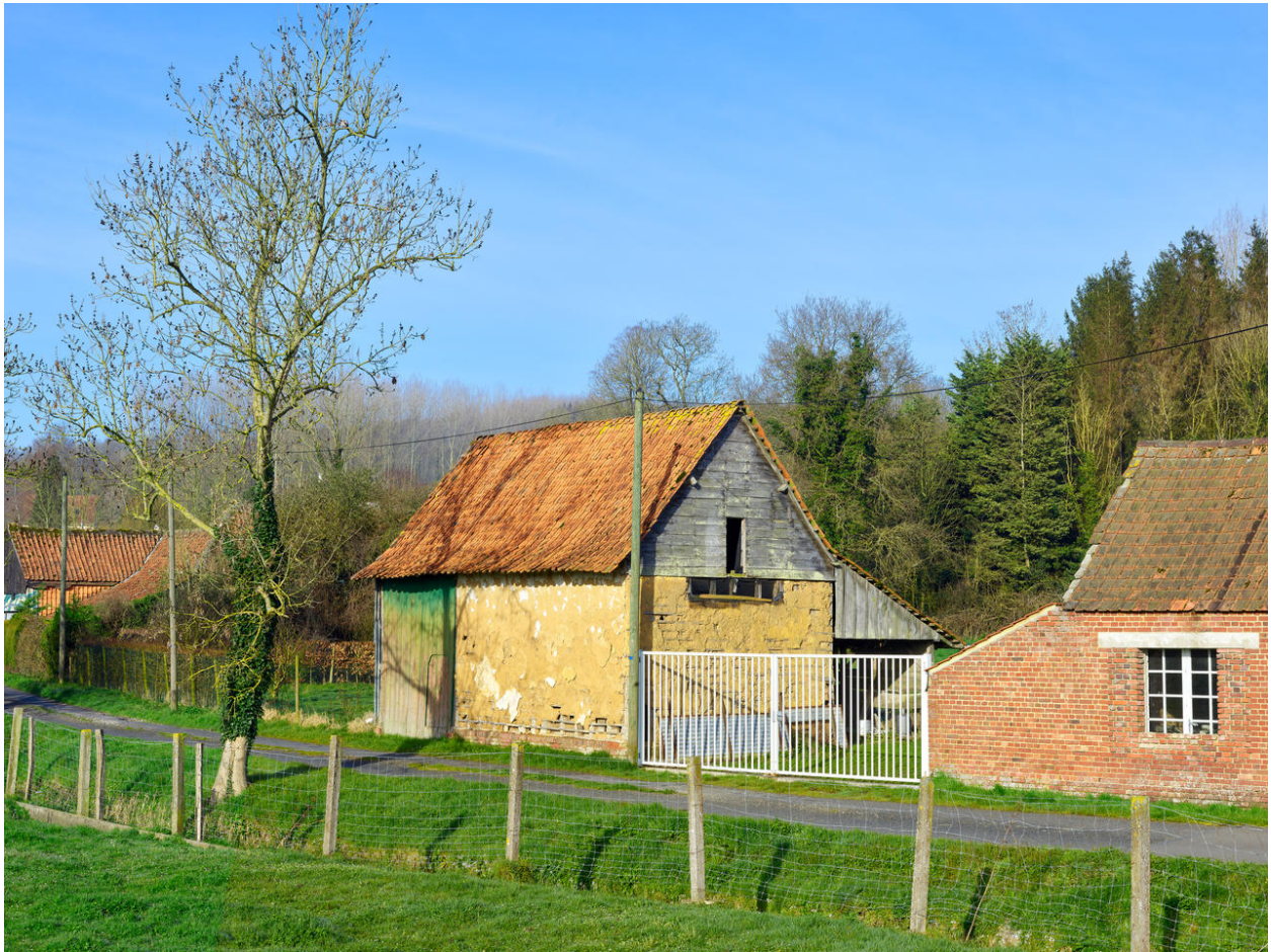
Vue de la grange en torchis depuis le sud-est.
