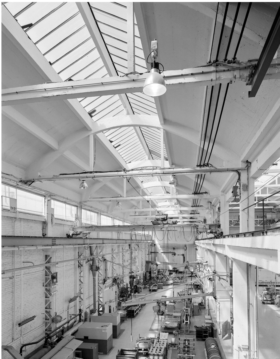
Vue générale intérieure de la halle 20 nord : l'atelier d'enrubannage.
