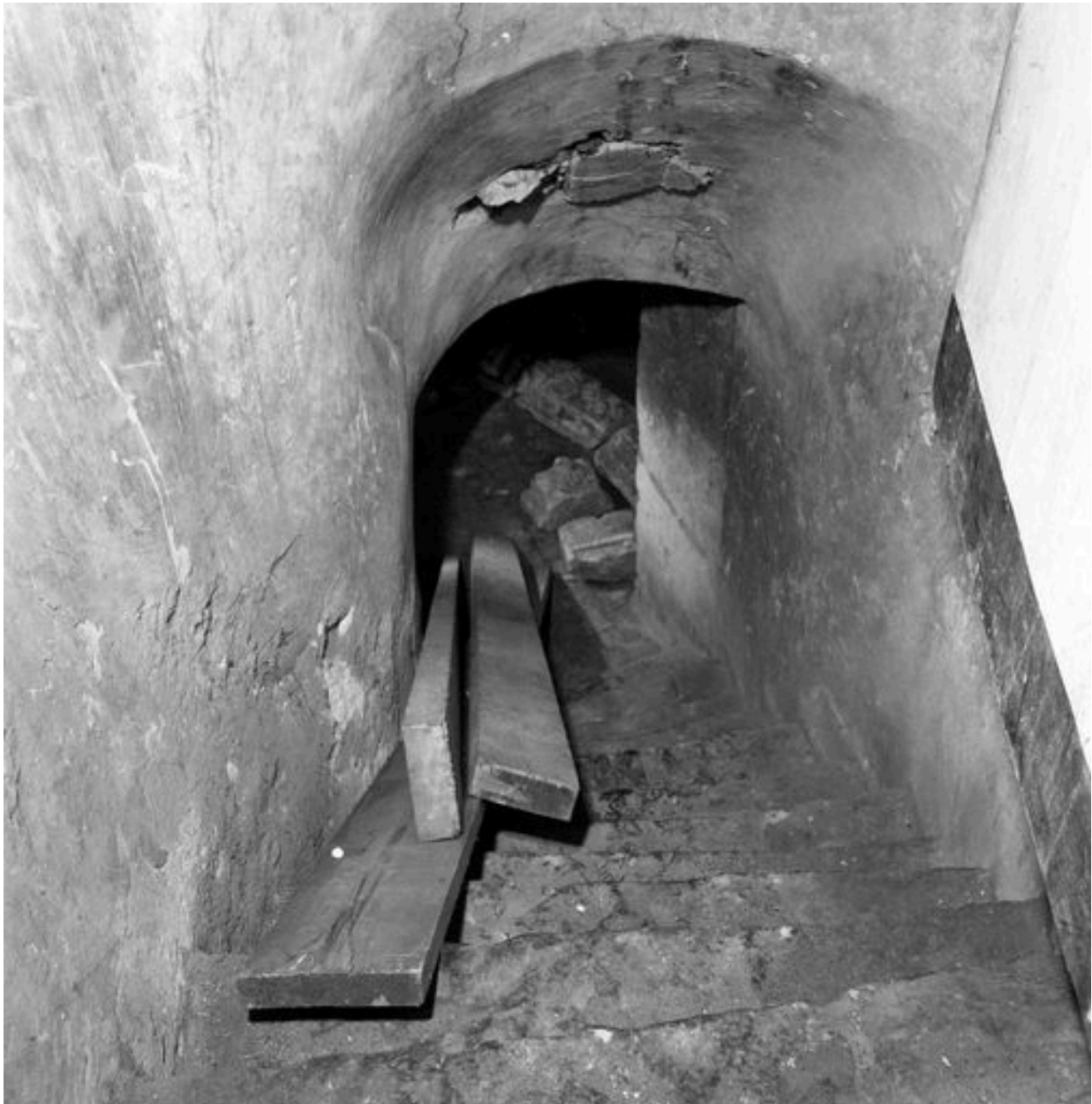
Corps de logis médiéval, intérieur, cave, escalier d'accès aménagé depuis le rez-de-chaussée de l'aile n° 35-37 rue de la Cavalerie : vue depuis le haut de l'escalier.
