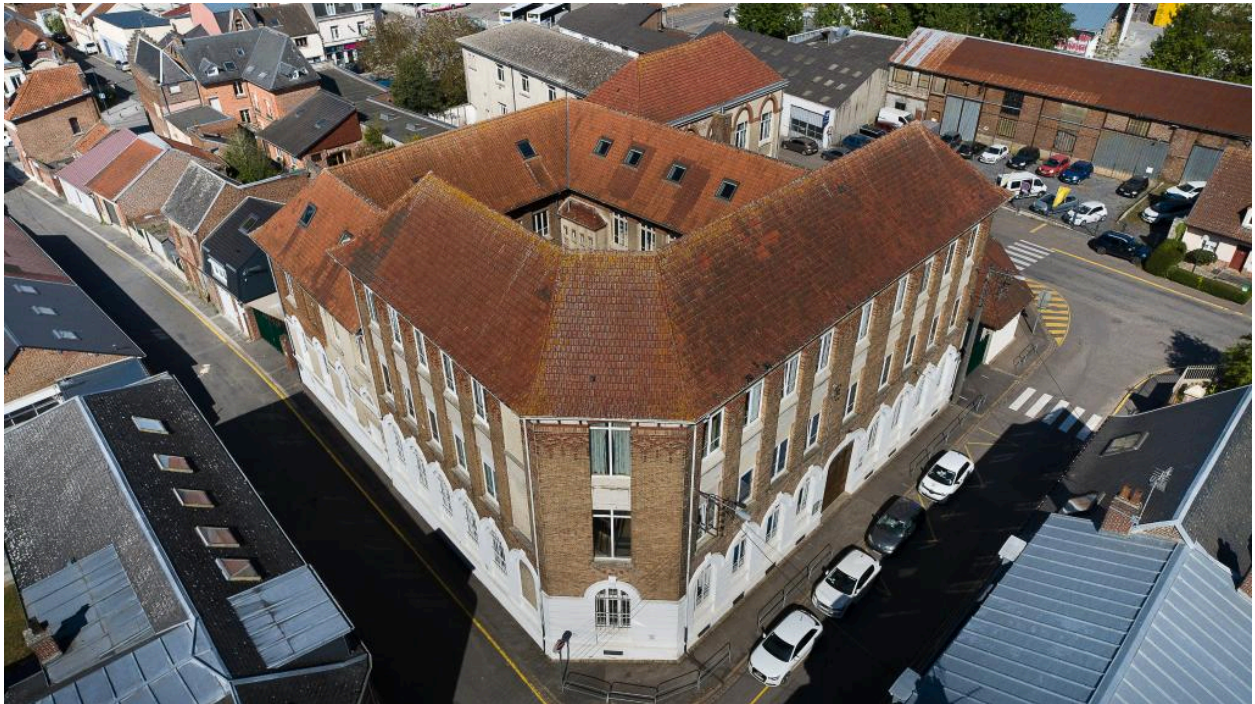
Vue arérienne générale de l'école depuis l'angle des rues Neuve et Lecointe.
