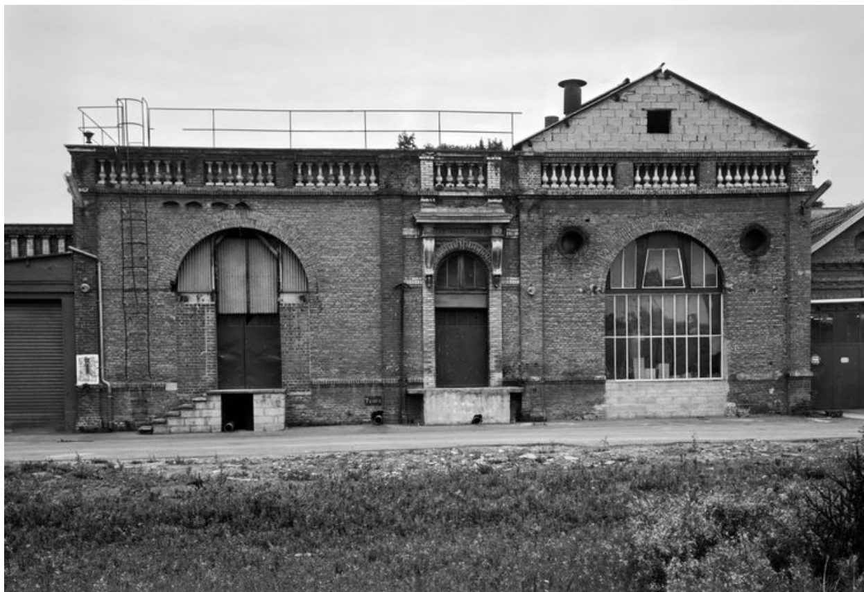
Chaufferie et salle des machines, flanc est.
