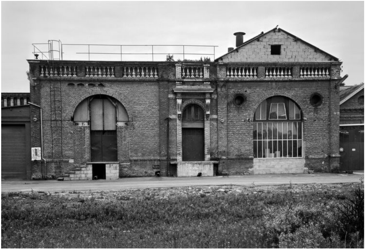
Chaufferie et salle des machines, flanc est.
