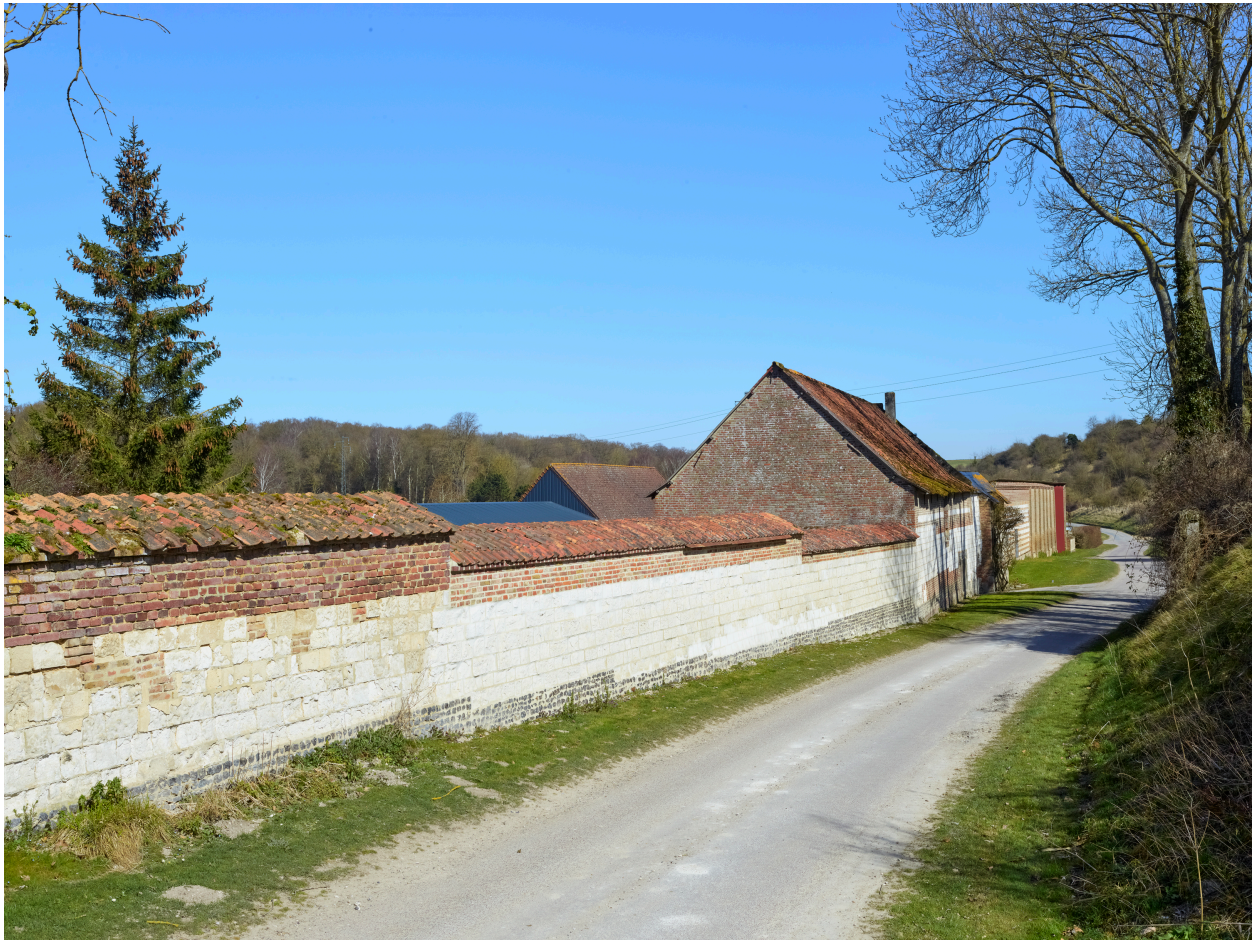
Mur de clôture de la ferme, depuis le sud.
