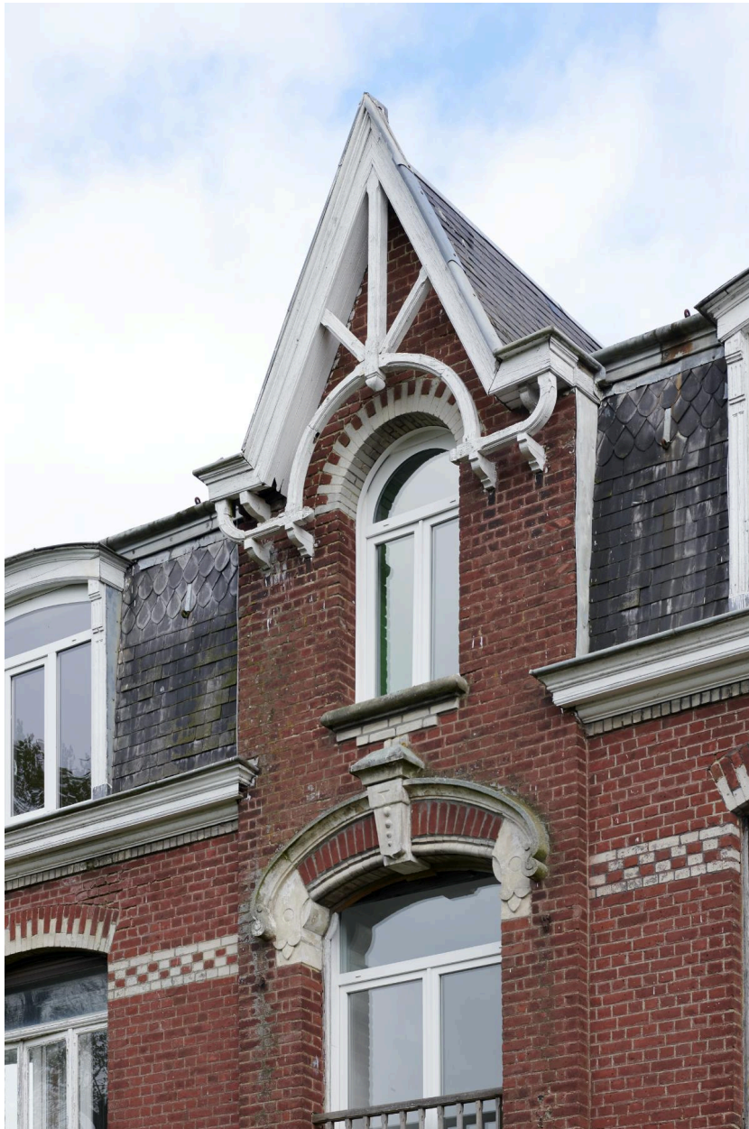
Détail de la partie supérieure de la travée centrale.
