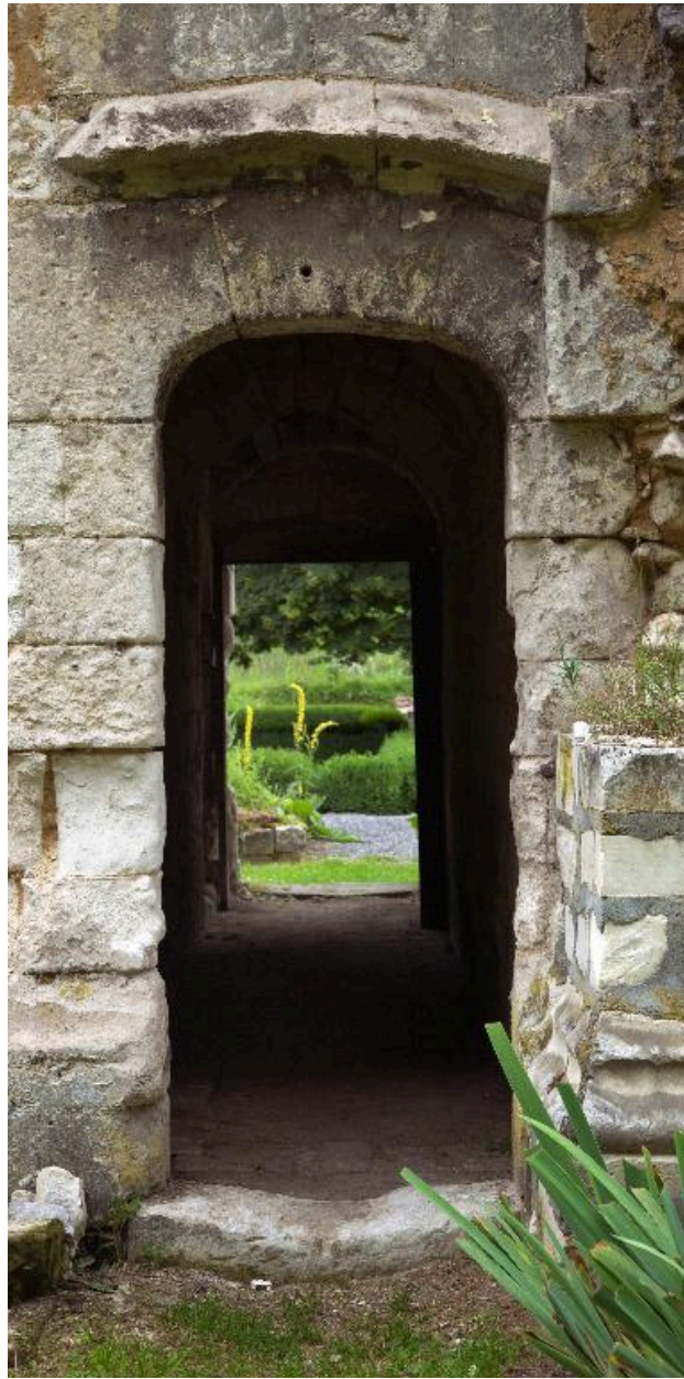
Porte d'un bâtiment prioral à l'est du cloître.
