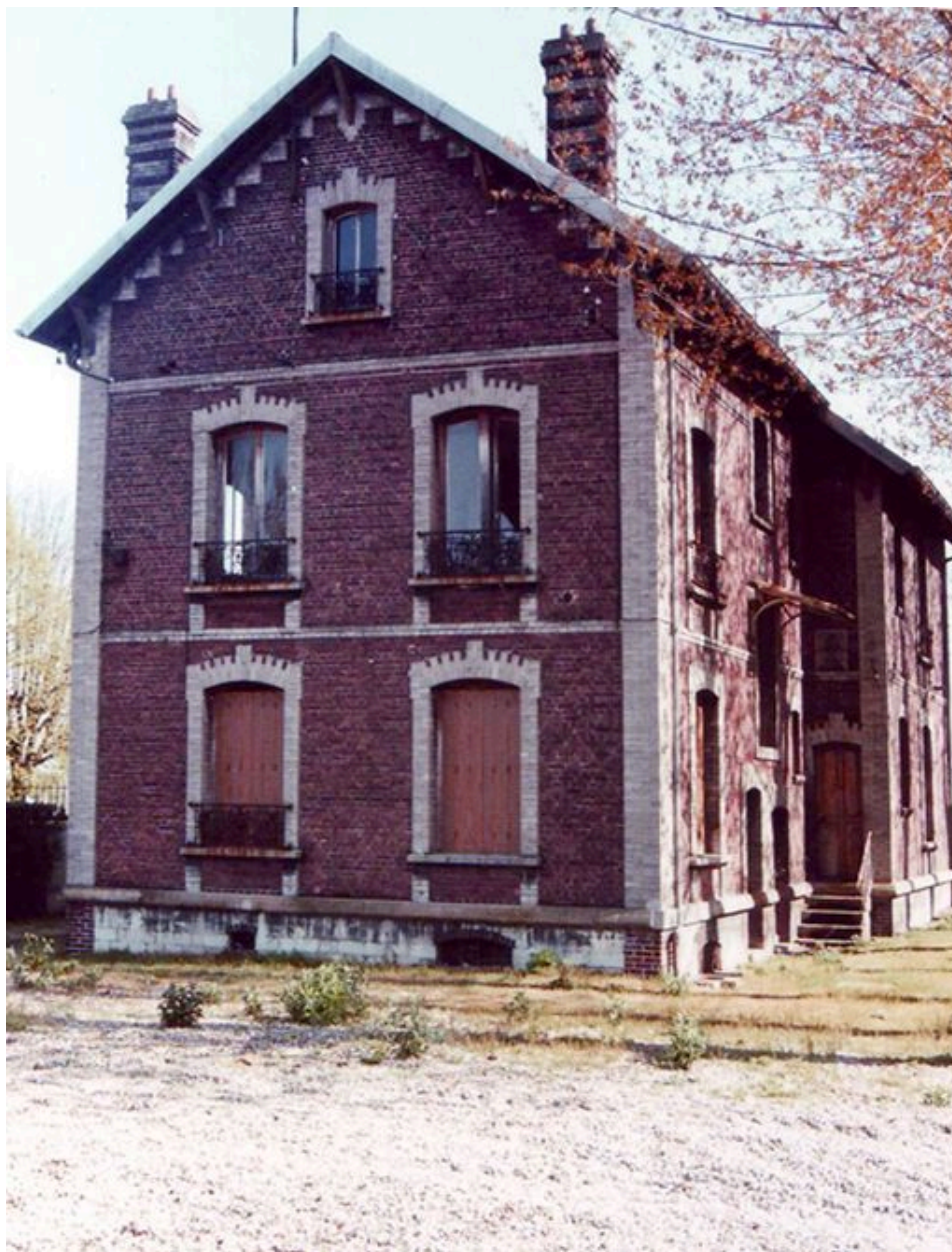
Façade ouest de la maison du directeur de l'usine des Ponts et Travaux en Fer prise en 1995 avant sa démolition (archives d'entreprise).
