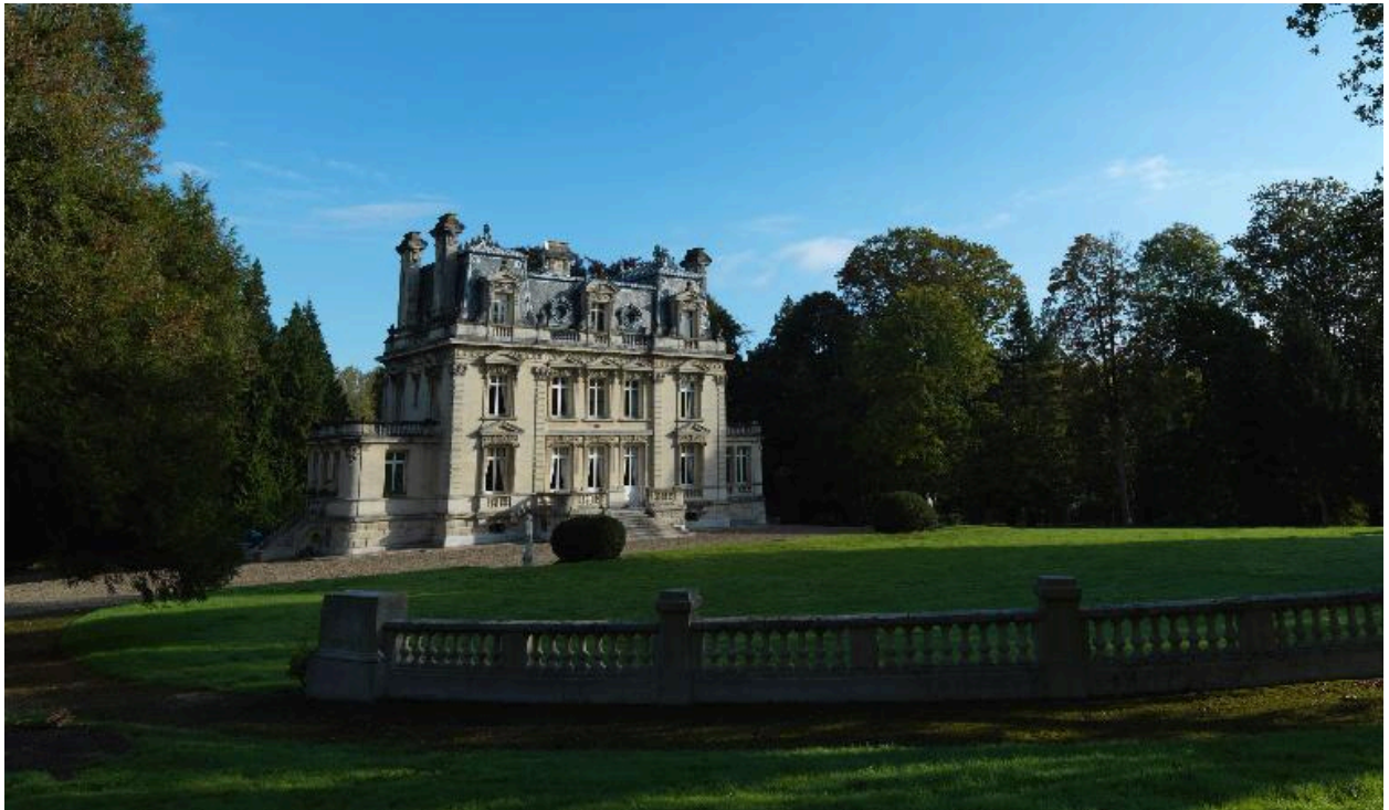
Façade arrière du logis depuis la balustrade.
