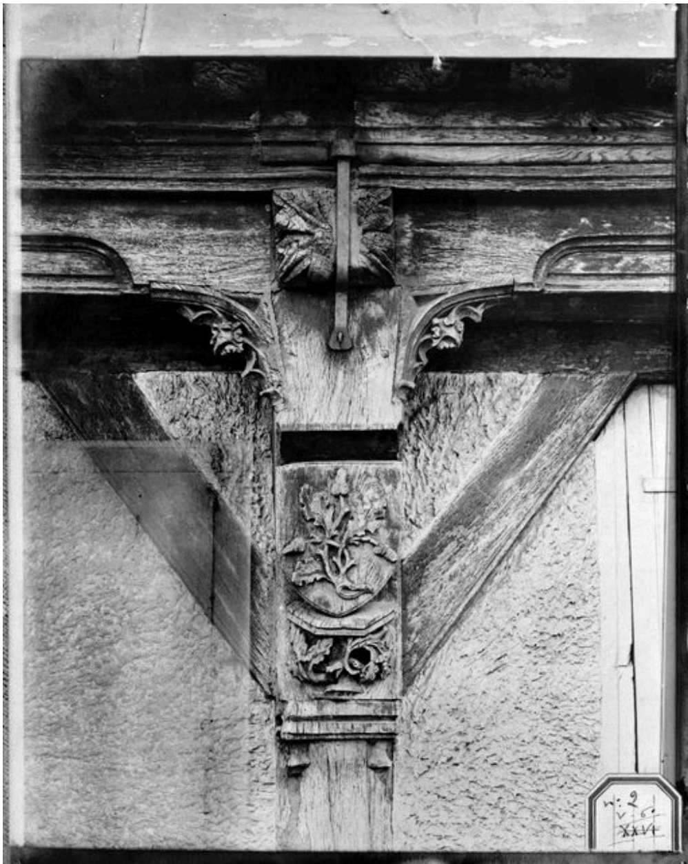
Détail poteau et sablière, avant 1914 (BM Compiègne).
