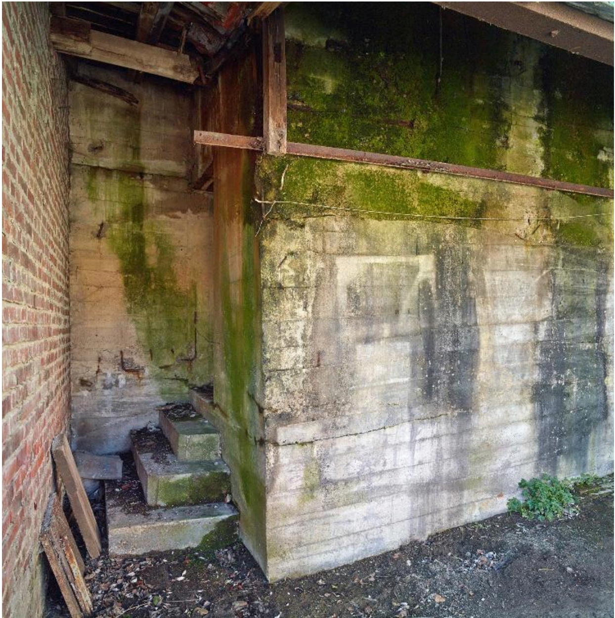
Partie nord de la casemate depuis la cour de la ferme. Entrée conduisant au premier niveau de l'édifice.
