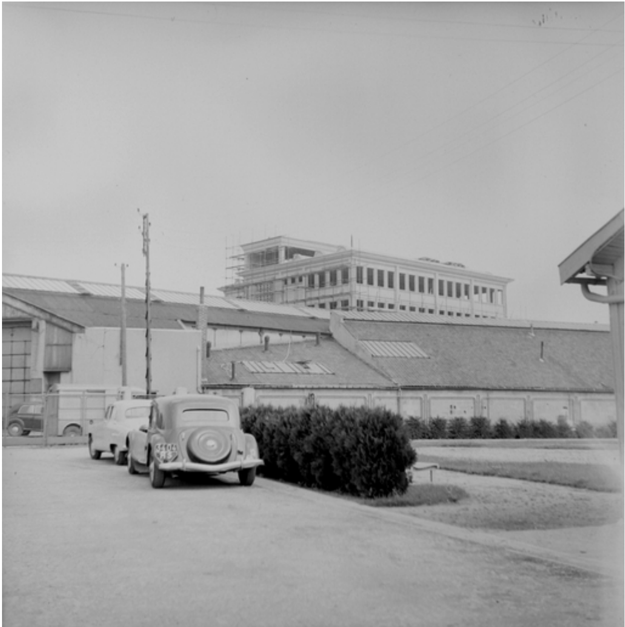
Les services généraux en construction, vus depuis la rue Lecat, vers 1950 (IFA).
