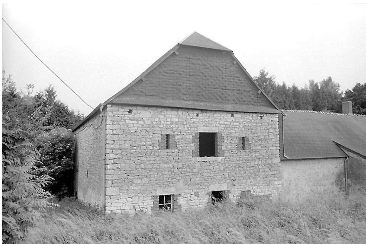
Elévation postérieure de la grange.
