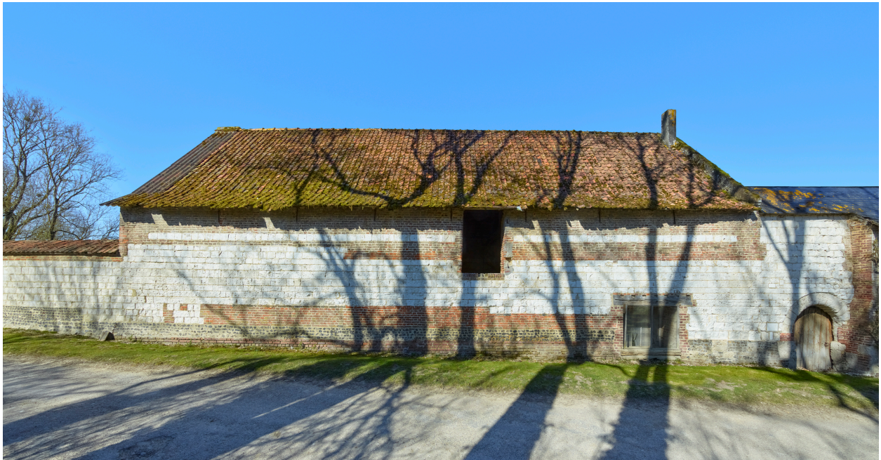
Grange, depuis l'est.
