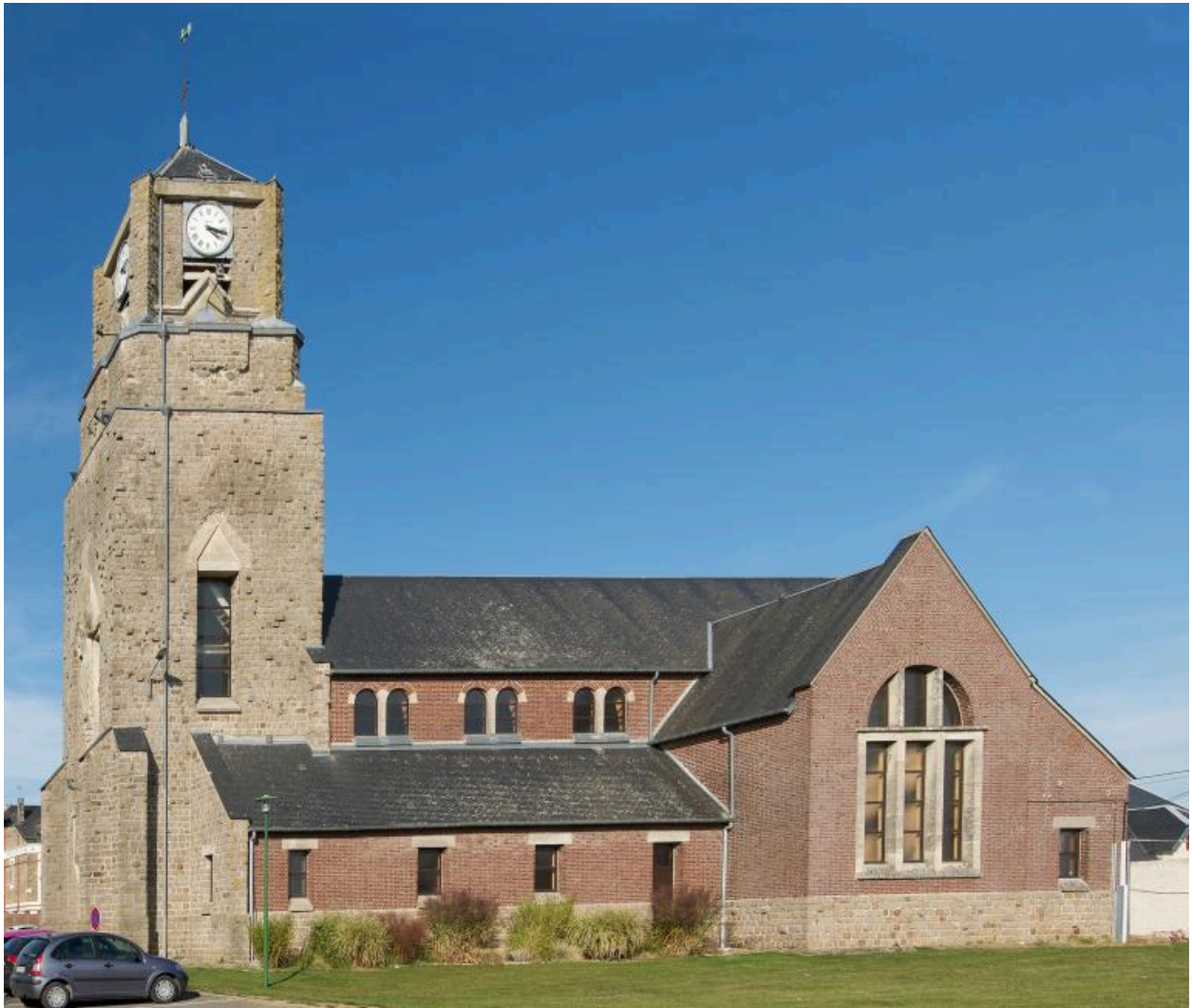
Façade latérale sud.
