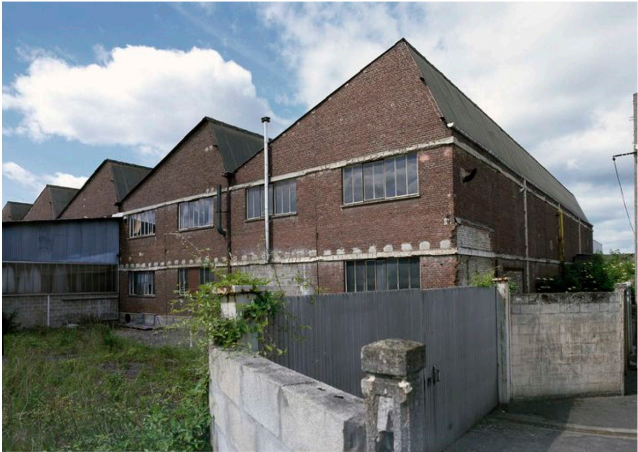
Ateliers de fabrication des postes de soudure.
