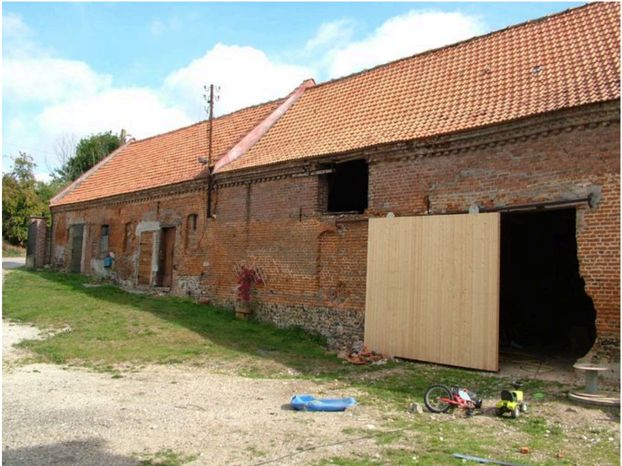
Vue des bâtiments d'exploitation bordant la cour à l'est.
