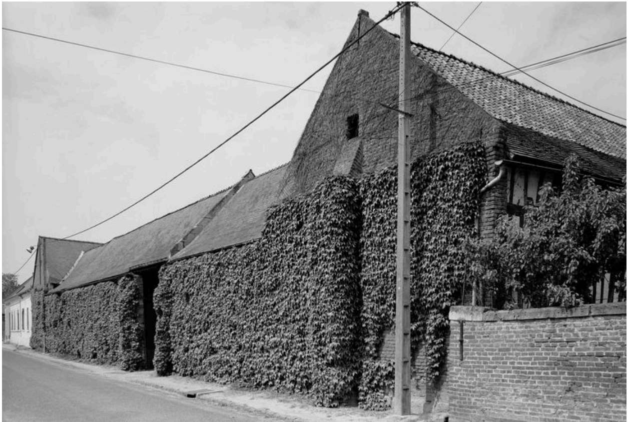
Vue générale sur rue.
