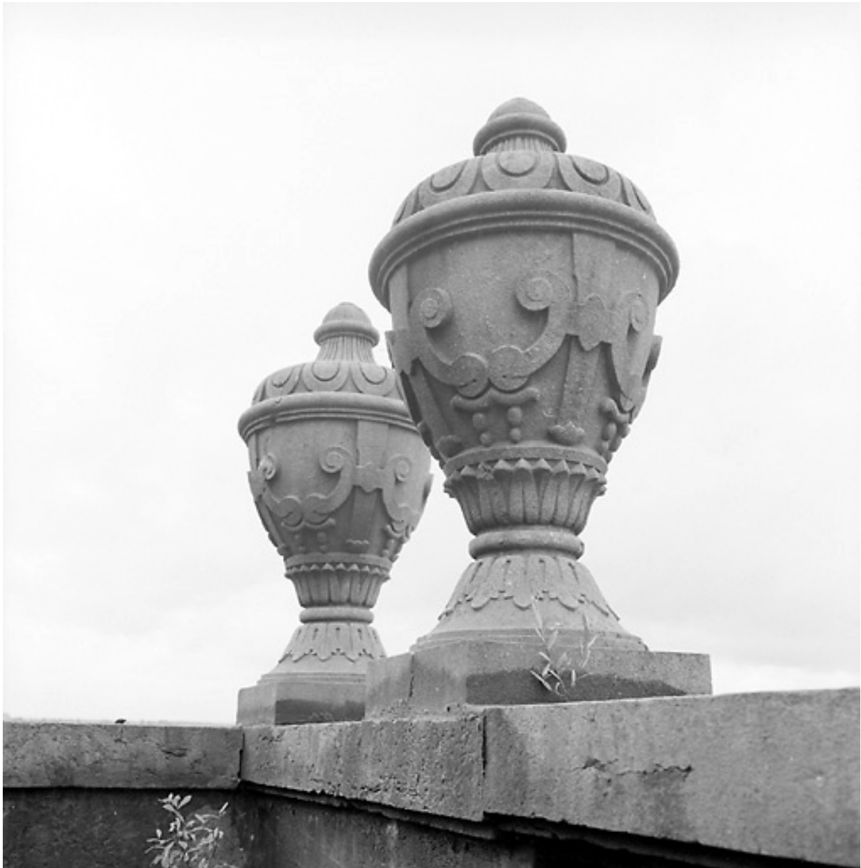
Façade : vases Médicis en pierre sommant la balustrade devant le comble.
