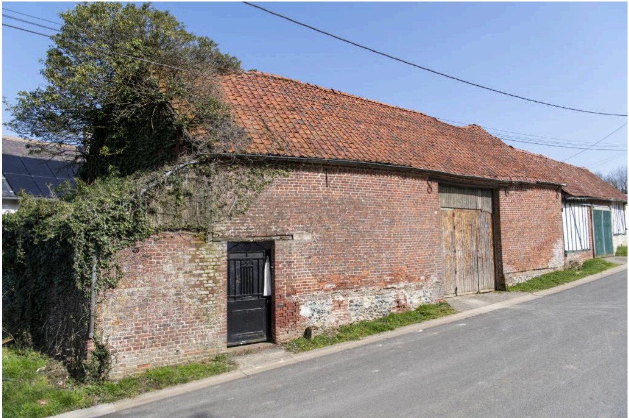
Ancienne grange sur rue reconstruite en 1868, n°13 rue des Fresnes, vue depuis le nord-ouest.
