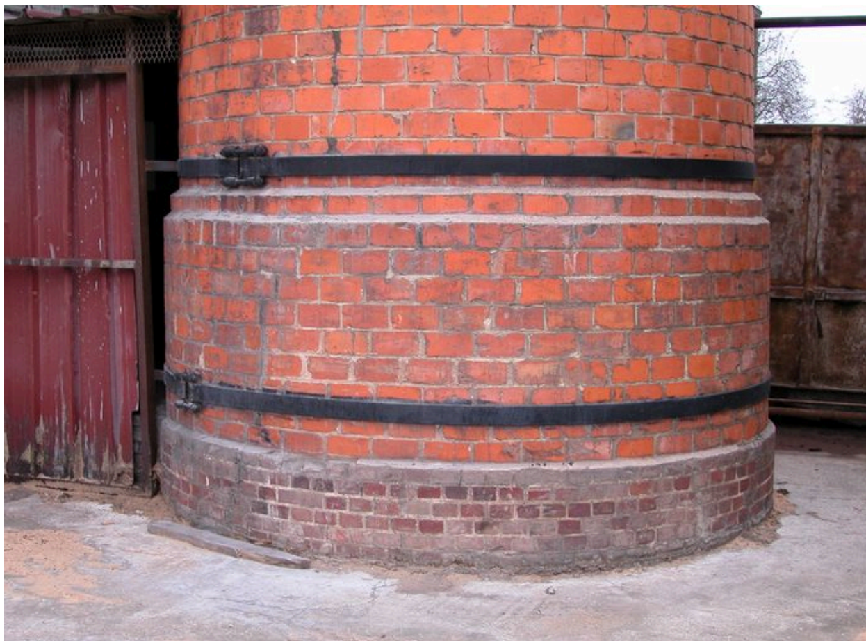
Détail du socle de la cheminée.
