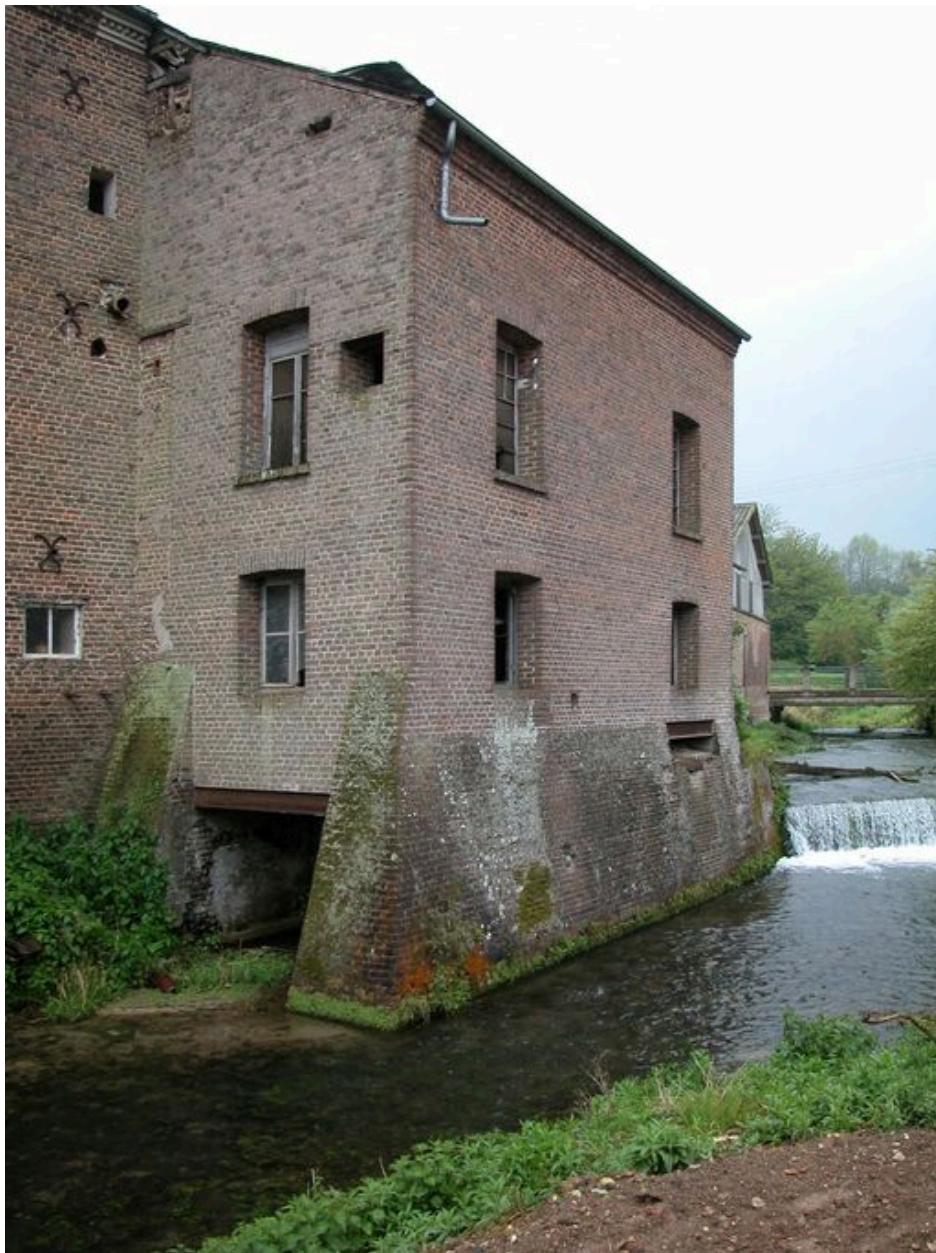
Le bâtiment d'eau.
