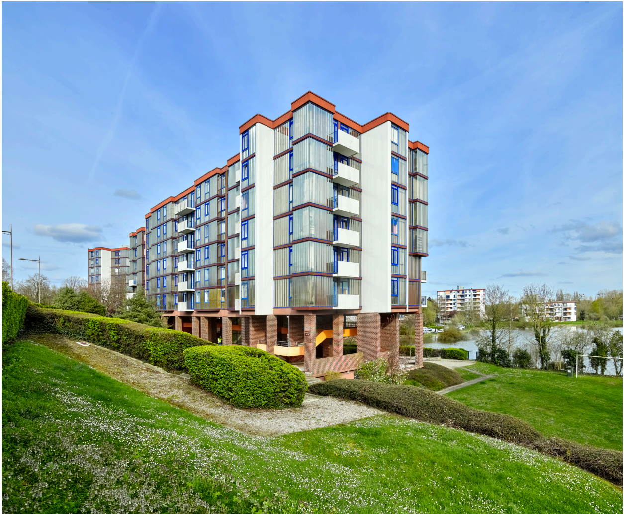
Vue du bâtiment G2 depuis le sud-ouest.
